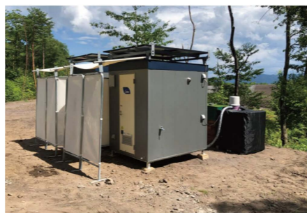
長野県 [工事現場 / WII型]
