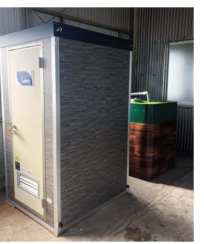
貸し倉庫内(静岡県)
